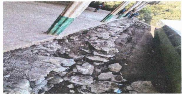
Foto 4: se observa que el muro de contencion se esta derrubando y pone en riesgo el establecimiento
