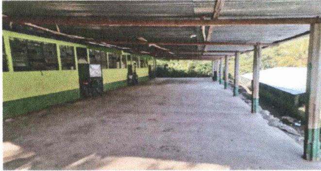
Foto 1: se observa que la estructura es de madera y se encuentra en mal estado.
