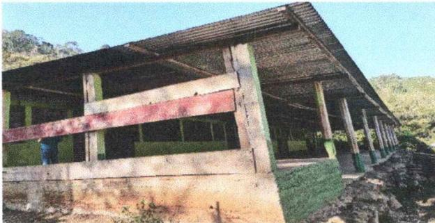
Foto 5: se observa que el muro de contencion se esta derrubando y pone en riesgo el establecimiento
