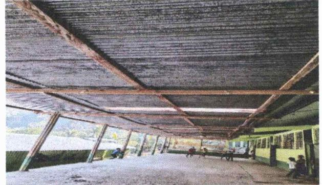
Foto 2: se observa que que la estructura metalica (lamina) se encuentra en mal estado y filtra agua en el corredor del establecimiento
